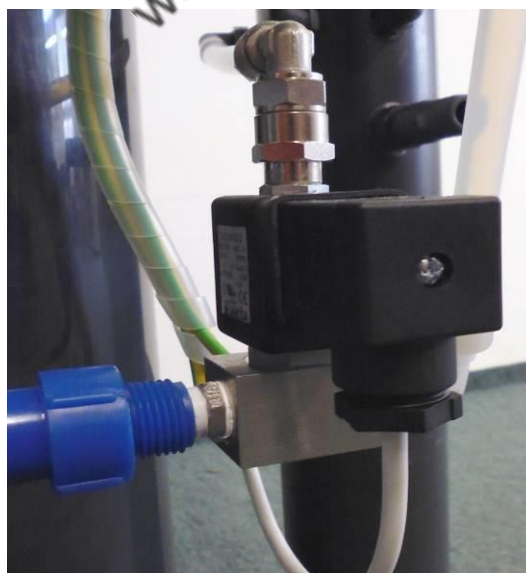
Рис. 6 Замена электромагнитного клапана O 3
